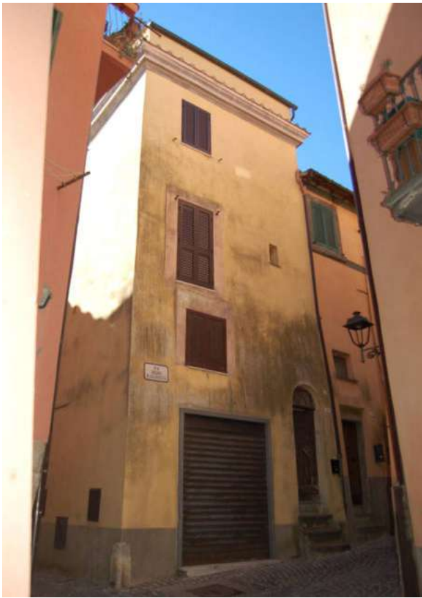
Foto 9 - Prospetto principale su Via Regina Margherita
