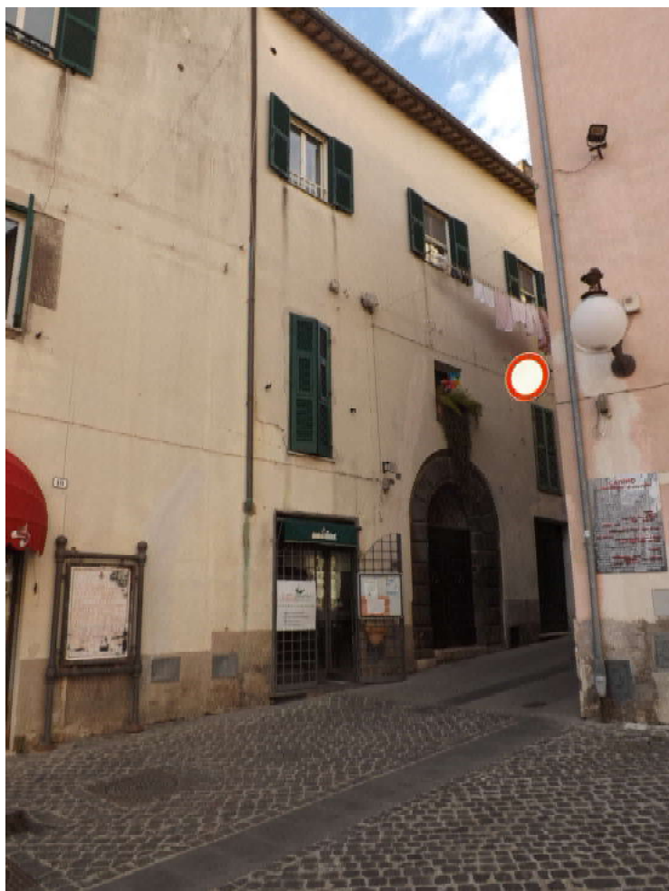
Foto 2 – Prospetto su Via Cavour
